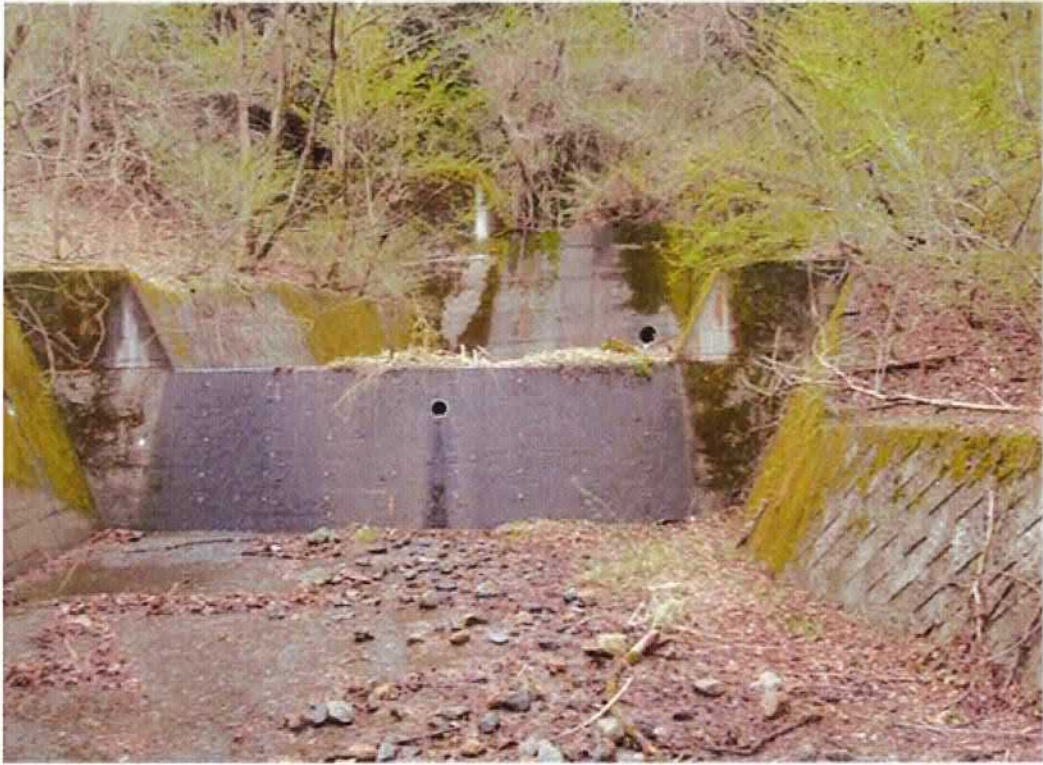
写真 1-4-1 A沢三面張水路上流
