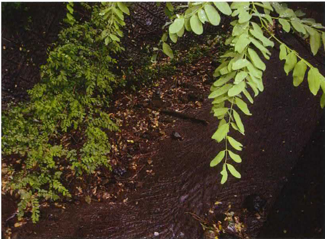
写真1-4-2 A沢三面張水路下流
