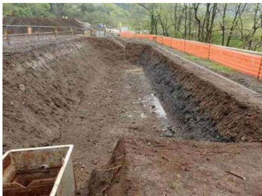
仮設沈砂池の規模
