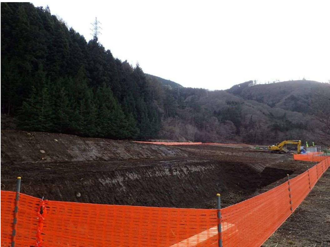
仮設沈砂池と仮設水路の写真（工事区域入口から西方向）
