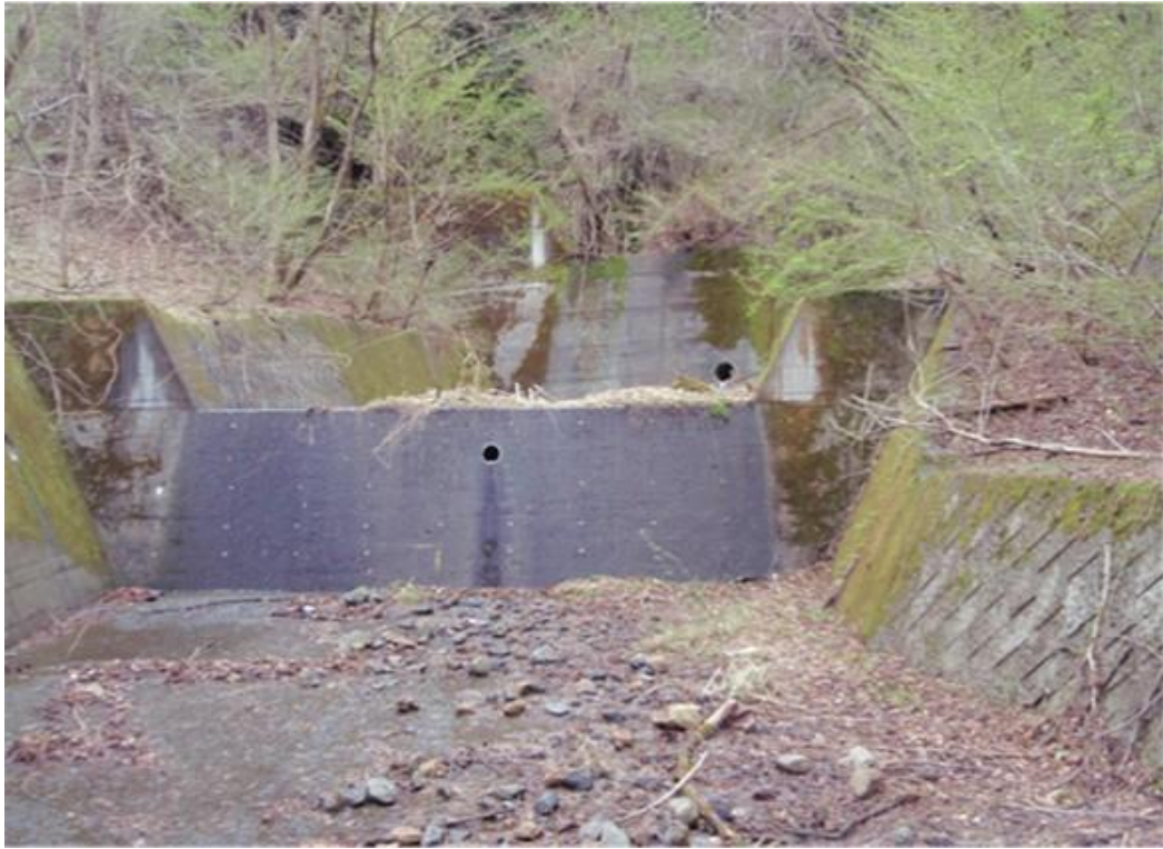
写真1-4-1 A沢三面張水路上流
