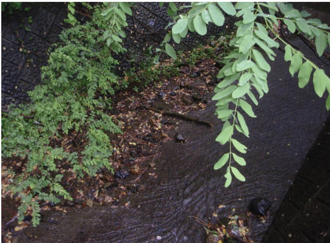
写真1-4-2 A沢三面張水路下流
